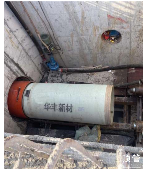
杭州市文一西路西延一期（狮山路-中心路段） 排水、中水工程
