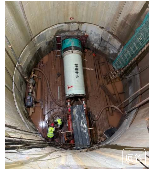
衢州市南湖补水提升泵站建设工程
