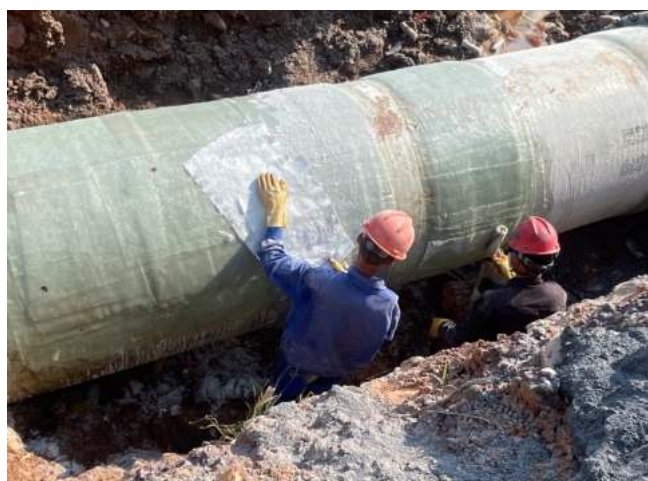
现场管道修复
